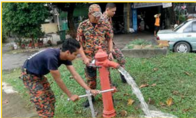
Ujian pengeluaran air pada Pili Bomba
